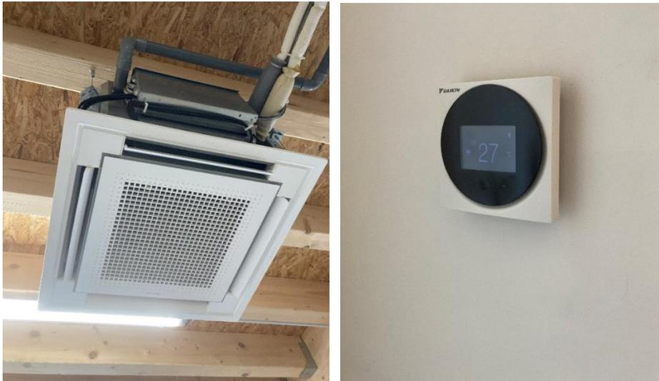
Photographie 1 : Cassette de climatisation à droite et régulateur de température à gauche
