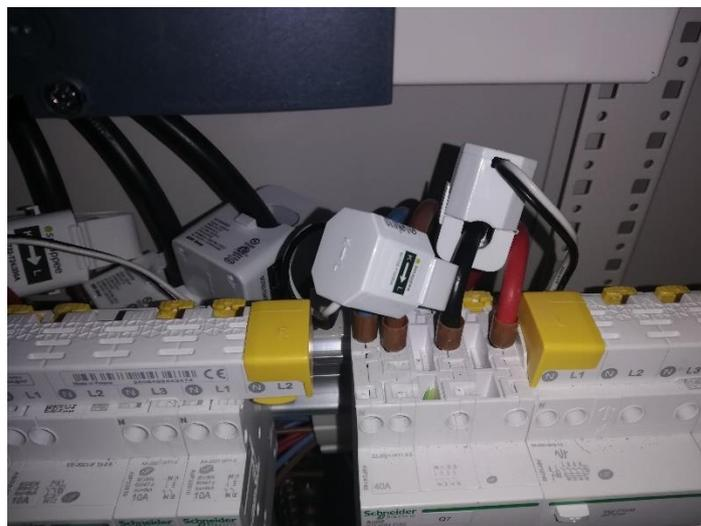
Photographie 7 : Pincas ampèremétriques installées dans le TGBT
