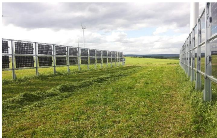
Photographie 3 : Installation photovoltaïque au sol avec des panneaux verticaux (Next2Sun)
